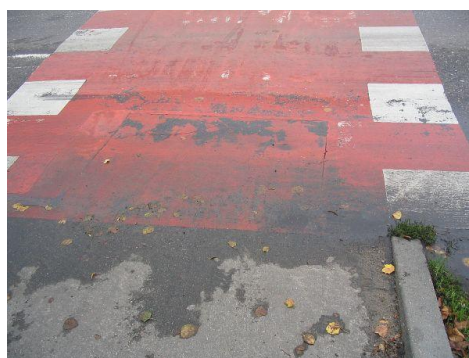
Zdjęcie 2 Bezszwowe łączenie nawierzchni DDR z jezdnią w miejscu przejazdu rowerowego (fot. Rowerowy Białystok)
